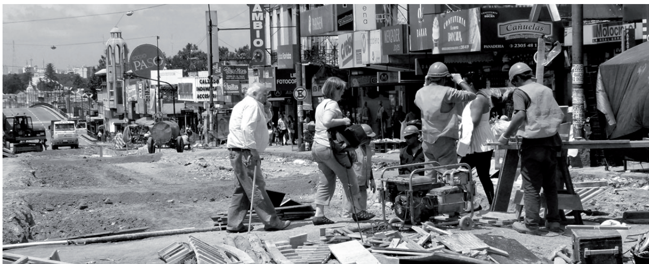
Obras en Av. Agraciada.
